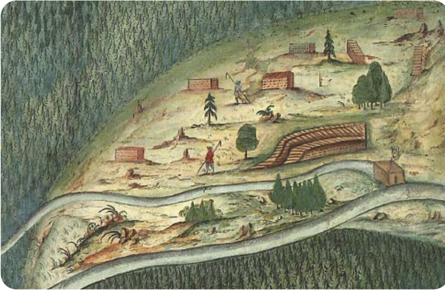
Die Abbildung zeigt das Wehrhaus in Fleyh um 1630. An dieser Stelle wird Wasser aus der Flöha in den Neugraben abgezweigt
