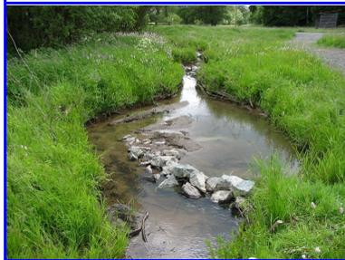
Dazu wurden die Seitenbäche auf die fünf- bis zehnfache Breite aufgeweitet. Durch einen Steinriegel bleibt der Hauptwasserstrom erhalten und der Bach kann bei Hochwasser Kies zum Hauptbach transportieren. Bei Normalwasser wird Schlamm abgelagert. Je nach Größe der Seitengewässer wurden ein bis drei solche Aufweitungen hintereinander angelegt. Der Schlamm muss jährlich geräumt werden. Im Frühjahr 2006 enthielt der Schlammfang im Bild mit insgesamt drei Aufweitungen 8,2 m<sup>3</sup> Schlamm.
